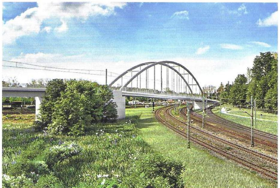
Visualisierung der RTW-Brücke über die Gleise vom Bahnhof Stadion nach Niederrad; man erkennt den für die geplanten Fernverkehrsgleise freigehaltenen Raum (Visualisierung: RTW Planungsgesellschaft).
